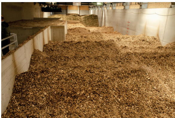
Das Lager ist auf eine autonome Versorgung von rund sechs Wochen ausgelegt. Die Schüttgrube fasst etwa 120 m 3 . Die Holzbeschaffung erfolgt innerhalb eines Radius von 100 Kilometern.
